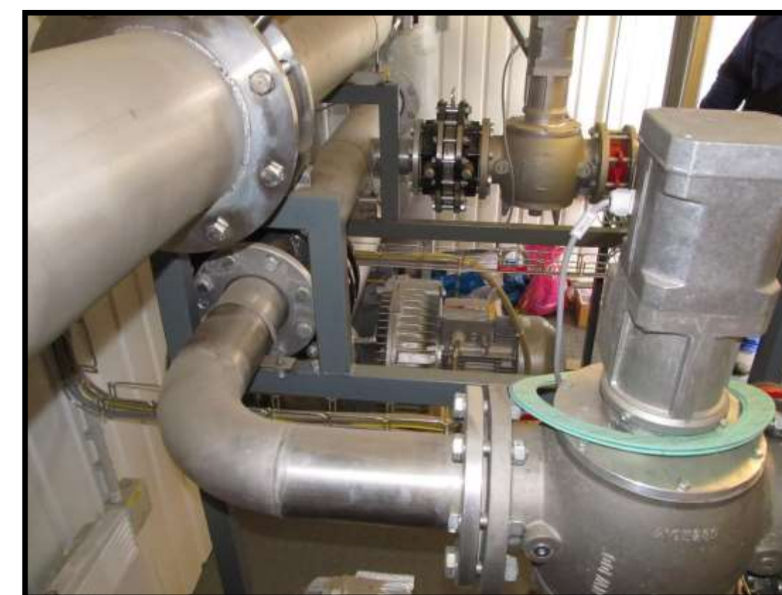
Stacja ciśnieniowa biogazu
