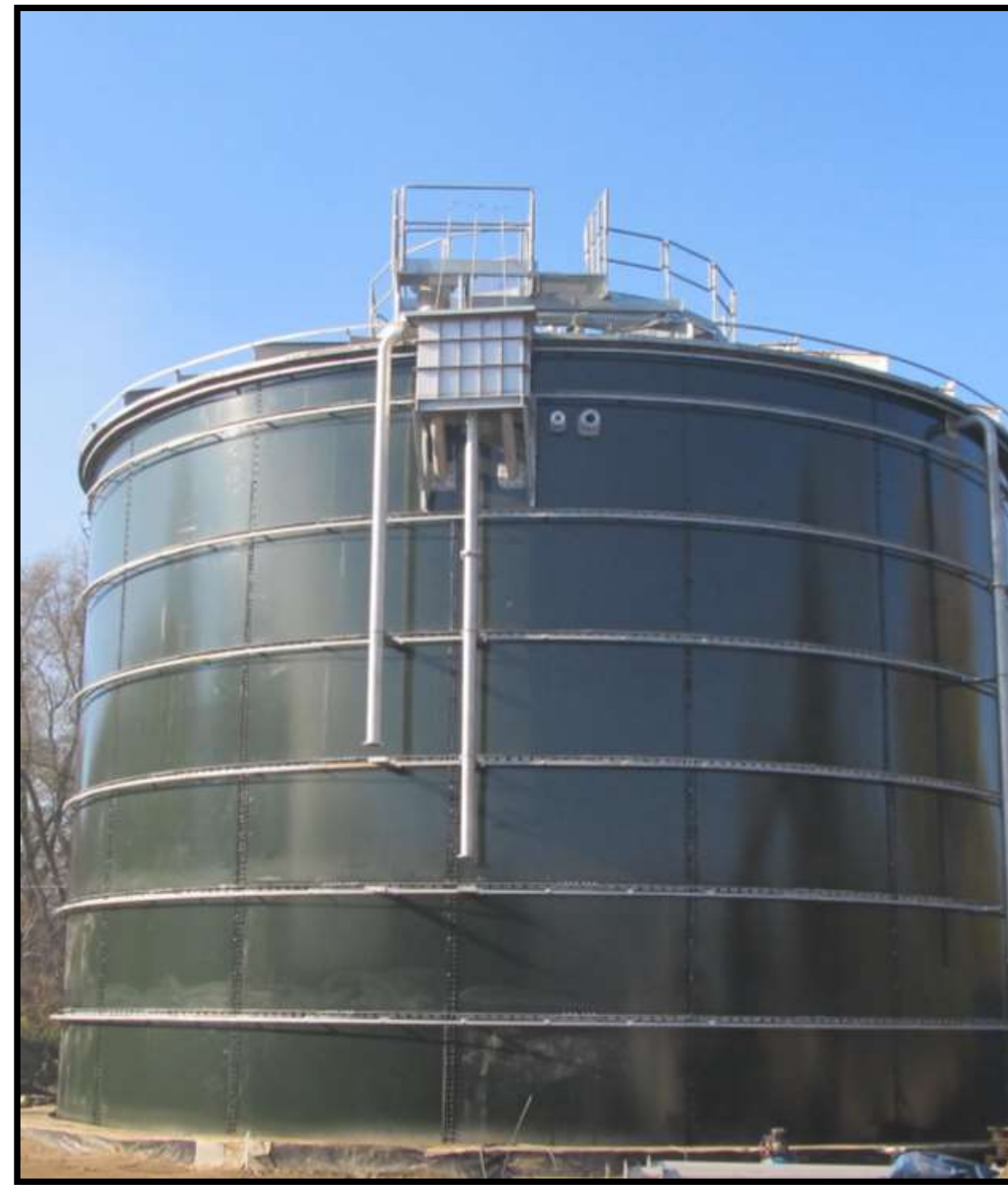
Dach stalowy, ze stali szklwionej
