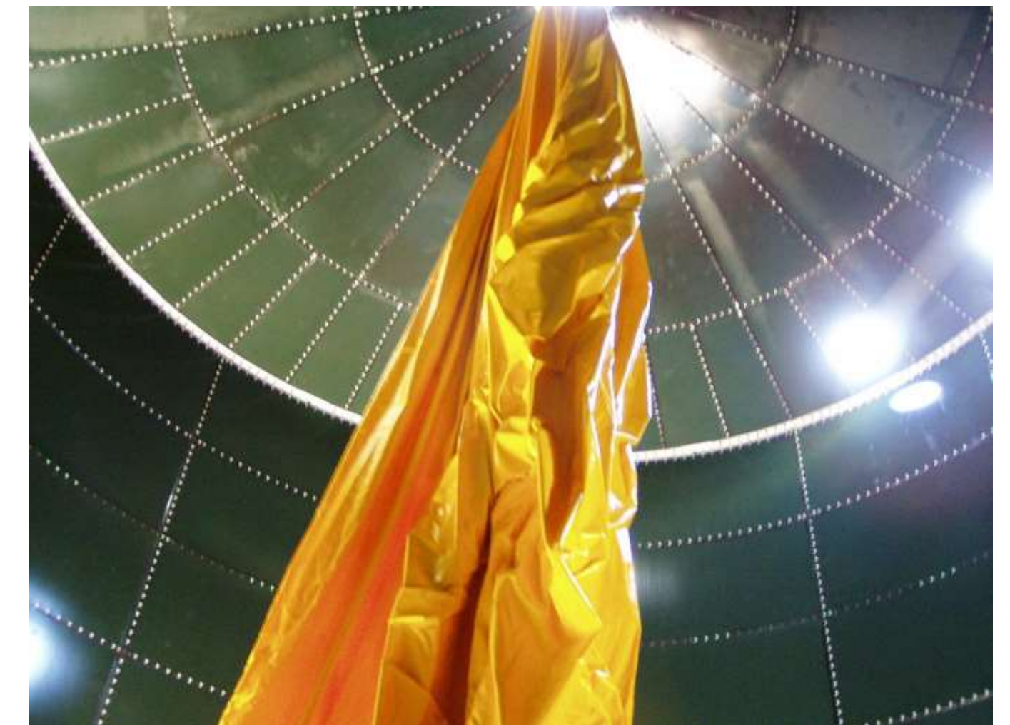
Balon gazowa w stalowym zbiorniku
