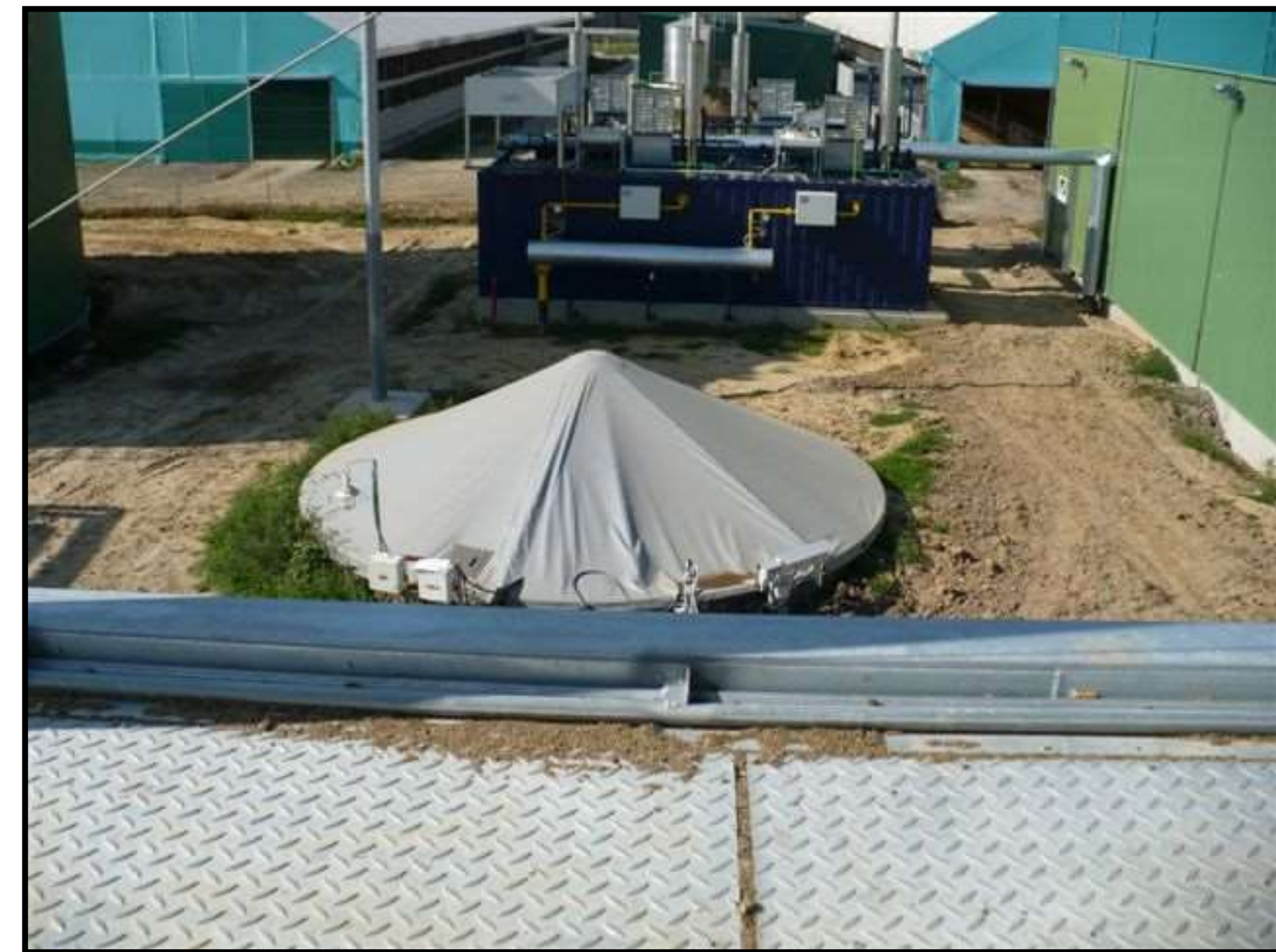
Dach plandekowy ze słupem centralnym
